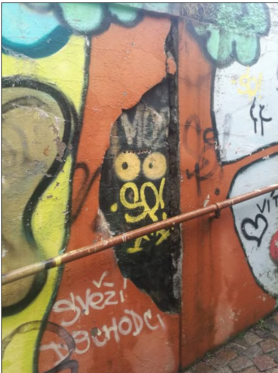
Obr. č. 10 - pohled na opady omítky v okolí dilatační spáry
