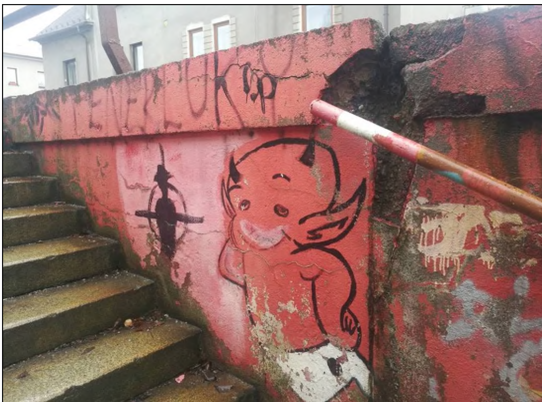
Obr. č. 6 - pohled na vlasové trhliny v líci zdi a opady betonu
