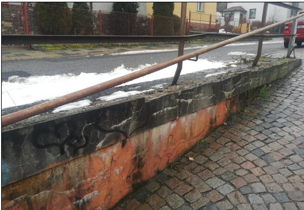
Obr. č. 8 - pohled na poškozenou římsu zdi
