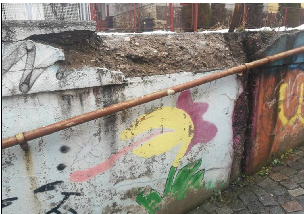
Obr. č. 7 - pohled na silně degradovanou římsu objektu
